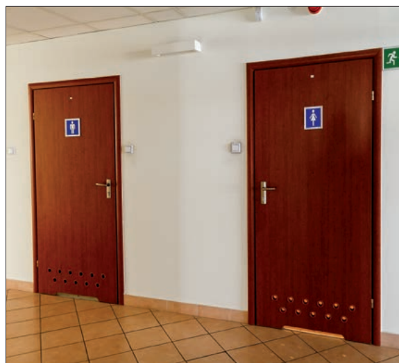
Wejścia do toalet powinny być odpowiednio oznakowane.
